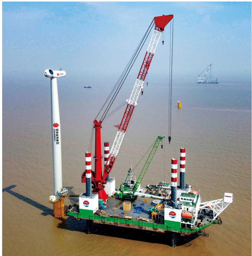
江苏大丰海上风电项目施工现场
