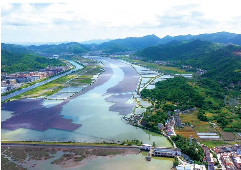
浙江温岭潮光互补型智能光伏电站
