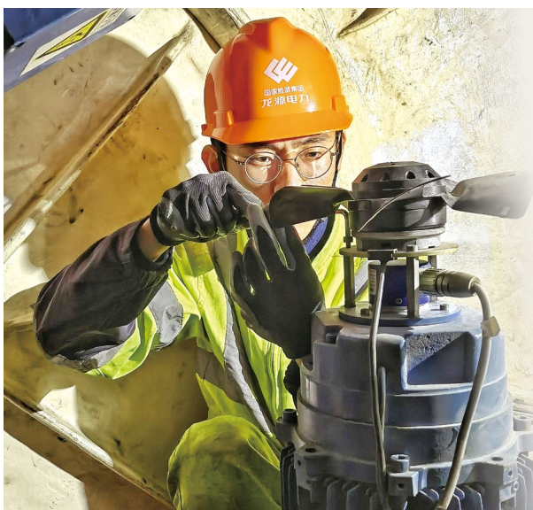
员工在风机内进行检修操作
